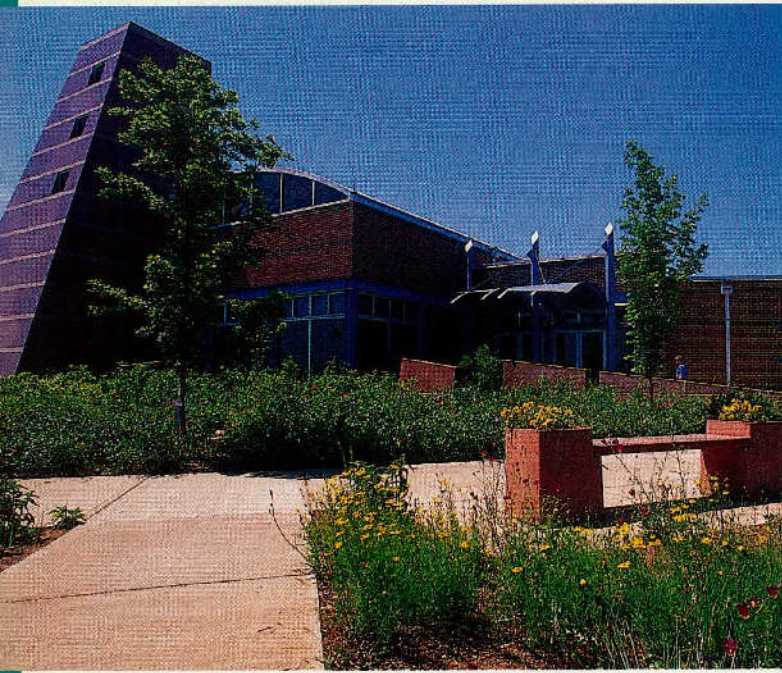
J. Griffin Smith/TXDOT
