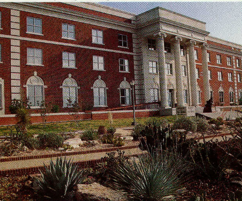
J. Griffiths Smith/TXDOT
