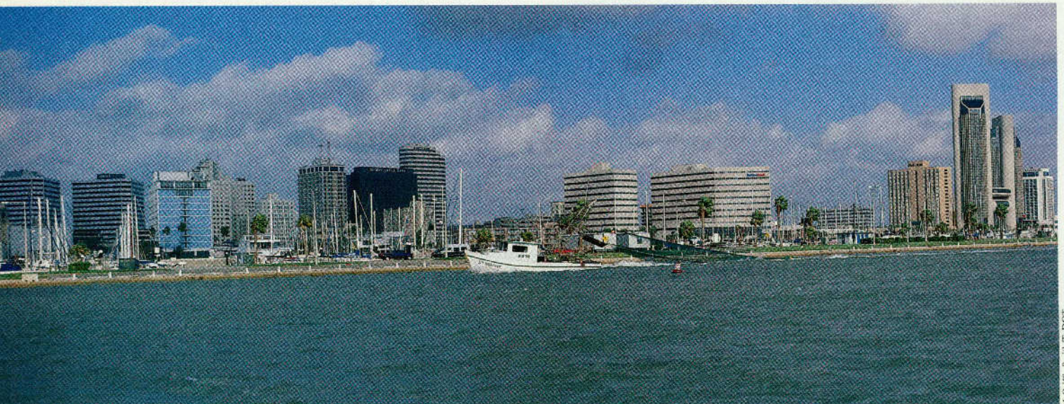
J. Griffin Smith/TxDOT
